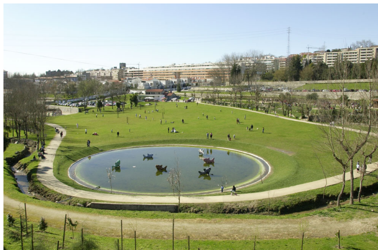
Figura 5 – Imagem da bacia de retenção instalada no parque da cidade do município de Guimarães, Portugal. Exemplo da integração da bacia ao perímetro urbano.
